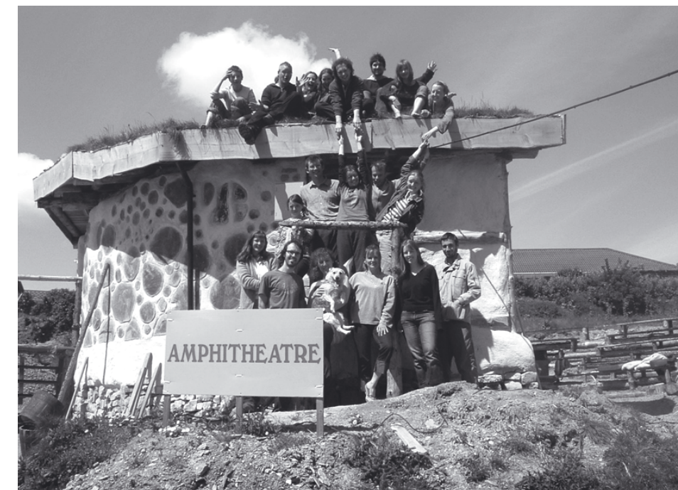
Het amfitheater van stro-leembouw en rondhout met specie is in 2005 net op tijd klaar.
